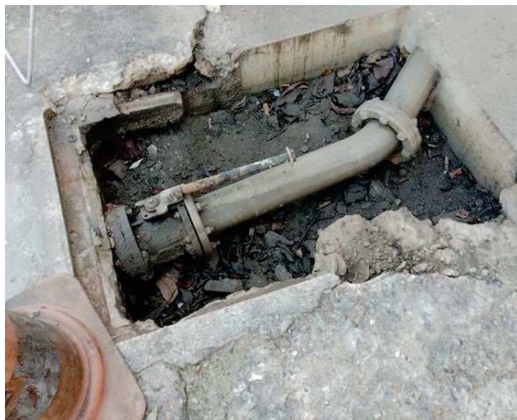
Illustration 16: Canalisation raccordée au réseau d'eaux usées. Source IIC
