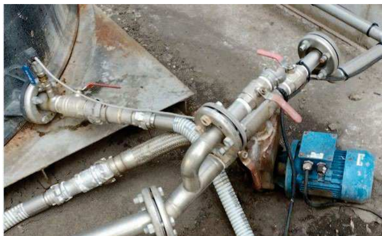
Illustration 2: Pompe servant au brassage du contenu de la cuve. Un piquage est visible. Source IIC.
