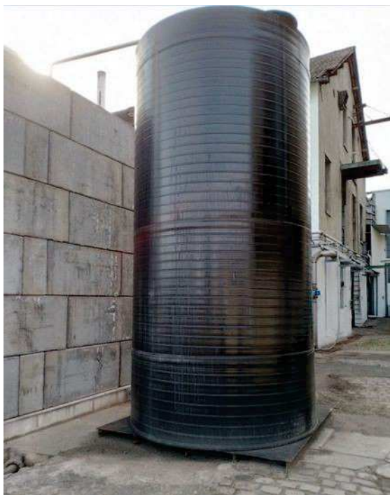
Illustration 1: Cuve noire qui récupère les eaux de ruissellement et les eaux du process. Source IIC.
