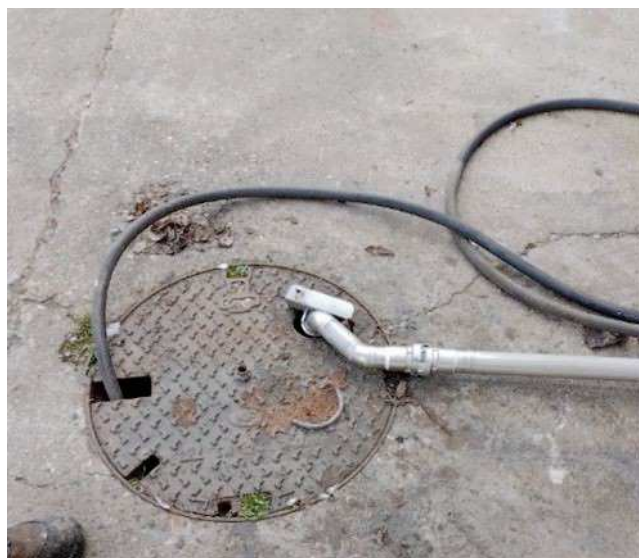
Illustration 3: Zone servant au pompage des eaux de ruissellement vers la cuve noire. Source IIC.
