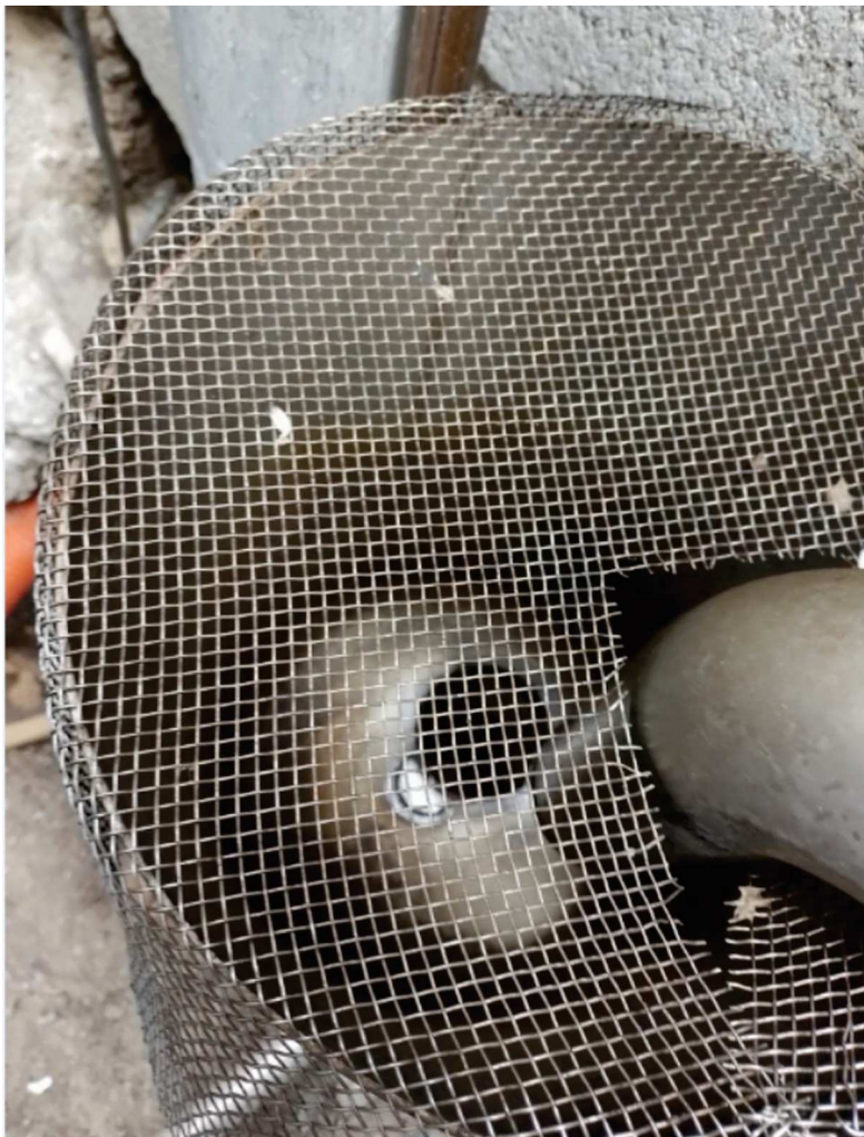
Illustration 15: Entonnoir présent en fin de circuit, juste avant l'accès vers le réseaux des eaux usées. Source IIC.
