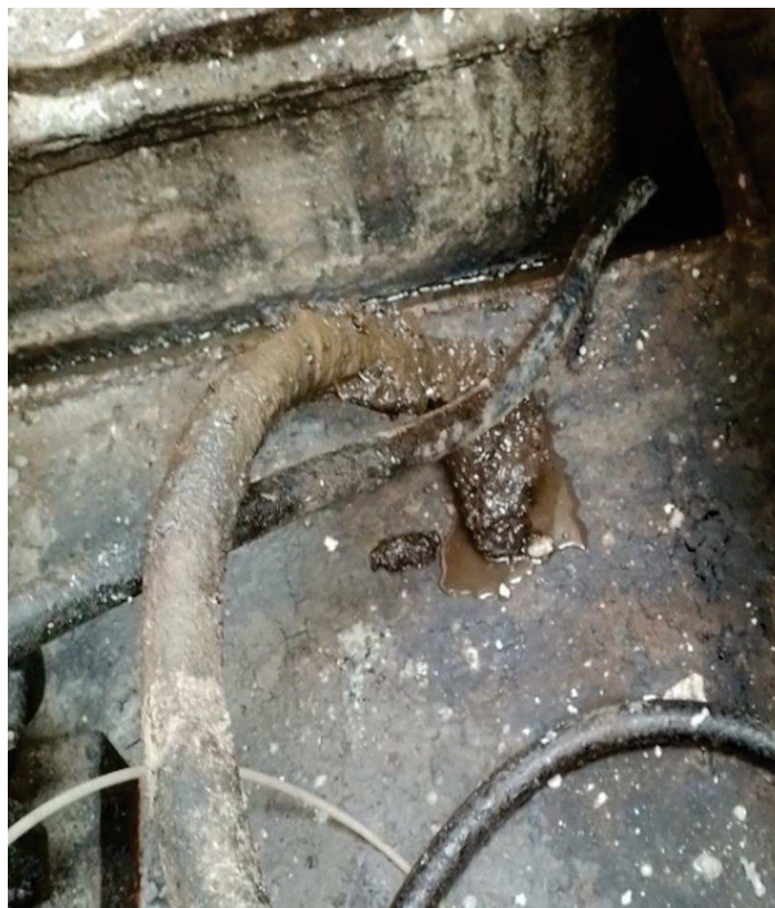
Illustration 6: Tuyau raccordé au décanteur retiré du regard. Source IIC
